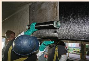
▲ FRP Sheet Wrapping
